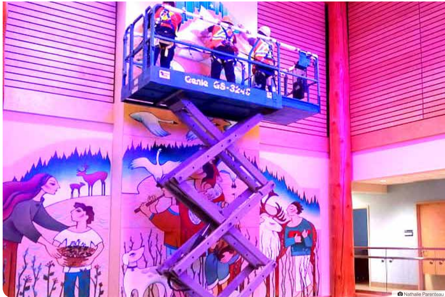
Installation de la nouvelle murale au Centre de soins prolongés Whistle Bend de Whitehorse.
